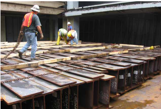
図31: ハッチ開口部に収納された入れ子I形梁の最初の段。しっかりと収納された形梁は、チェーンで甲板金物に固定されています
